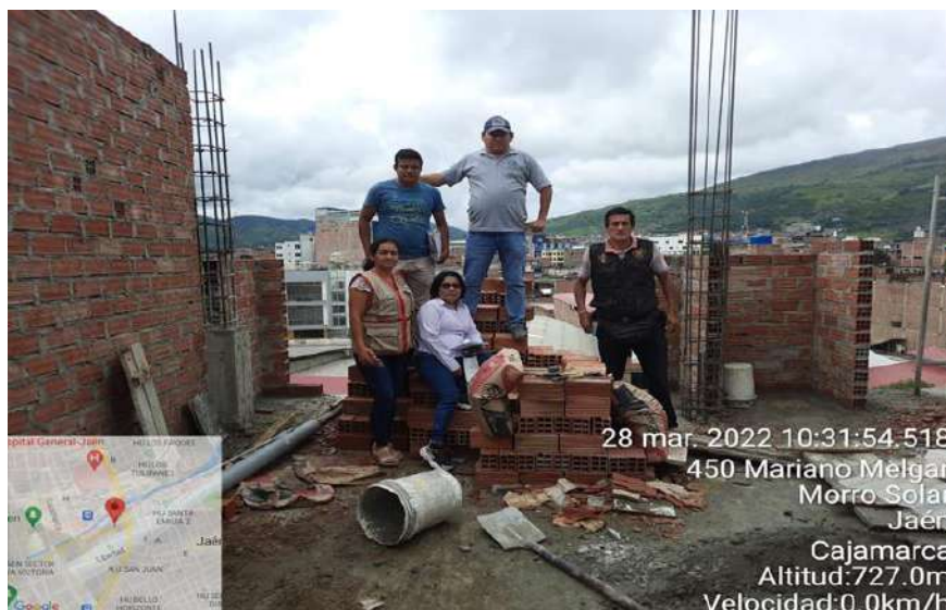
Supervisora de Obra haciendo seguimiento a las construcciones
