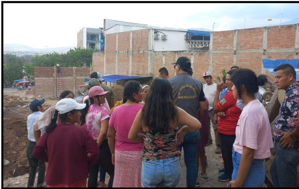
Intervención al sector donde se viene cerrando la vía pública en coordinación con la Sub Gerencia de Edificación de la MPJ
