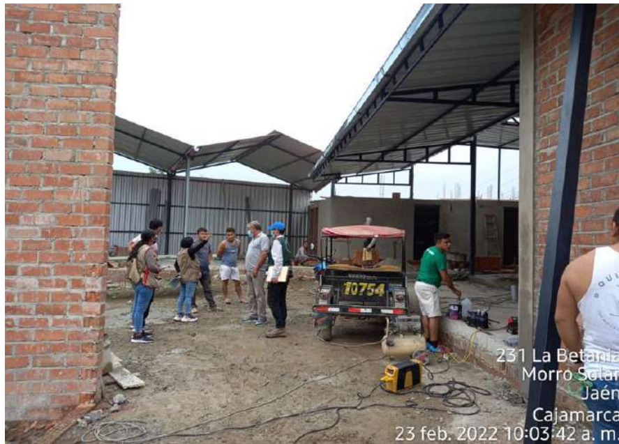
Supervisión de obra
