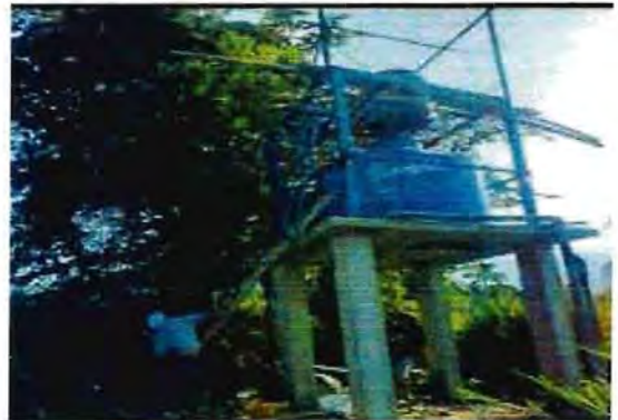
FOTO 33: Instalación de tanques y tubería.
