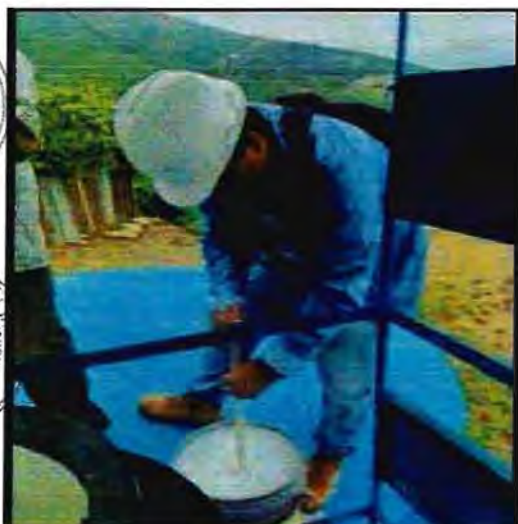
FOTO 21: Calibración del gotero del sistema de cloración
