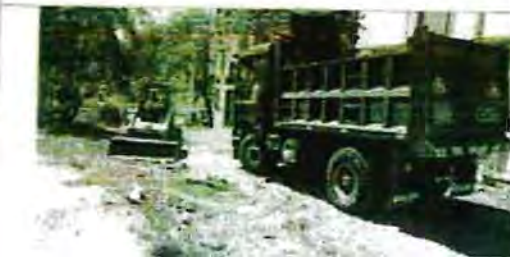
Figura Nº10 TRABAJOS INTERMEDIOS DE EJECUCIÓN DE ACTIVIDAD
