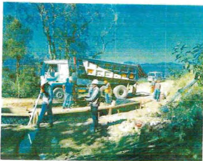
ENCOFRADO DE BADENES CON FINES DE CIMENTAR DRENAJES EN PLATAFORMA
