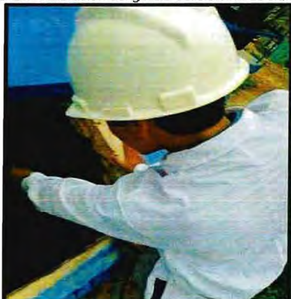
FOTO 21: Calibración del gotero del sistema de cloración
