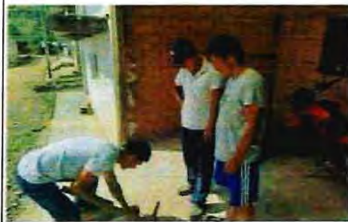
FOTO 48: Mantenimiento de Captación de agua de la JASS Santa Fe de las Naranjas.
