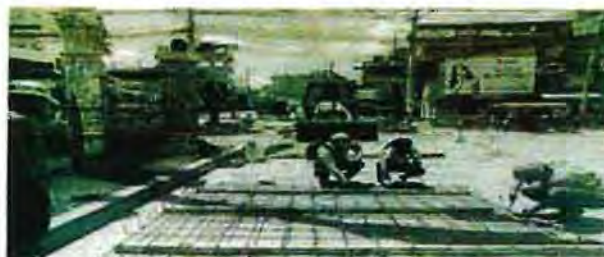
Figura 3 Armado de parrilla de acero
