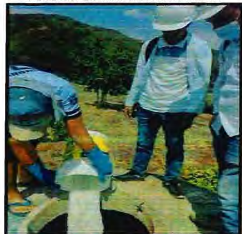
FOTO 08: Desinfección del reservorio.
