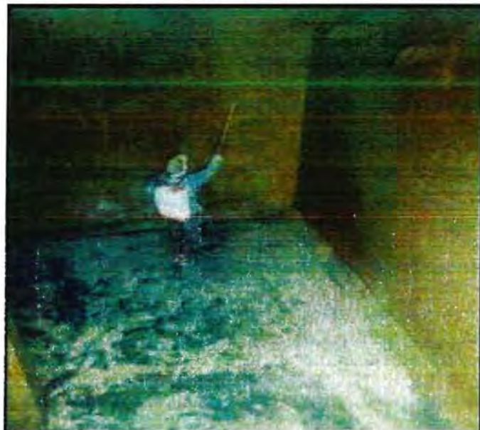
FOTO 18: Desinfección del reservorio de la Fila Alta
