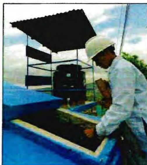
FOTO 62: Como último paso, se realiza la calibración y medición del cloro residual según la metodología establecida por la SUNASS, en cuatro puntos del sistema, empezando por el reservorio como componente directo donde se hace el vertimiento del hipoclorito de calcio.
