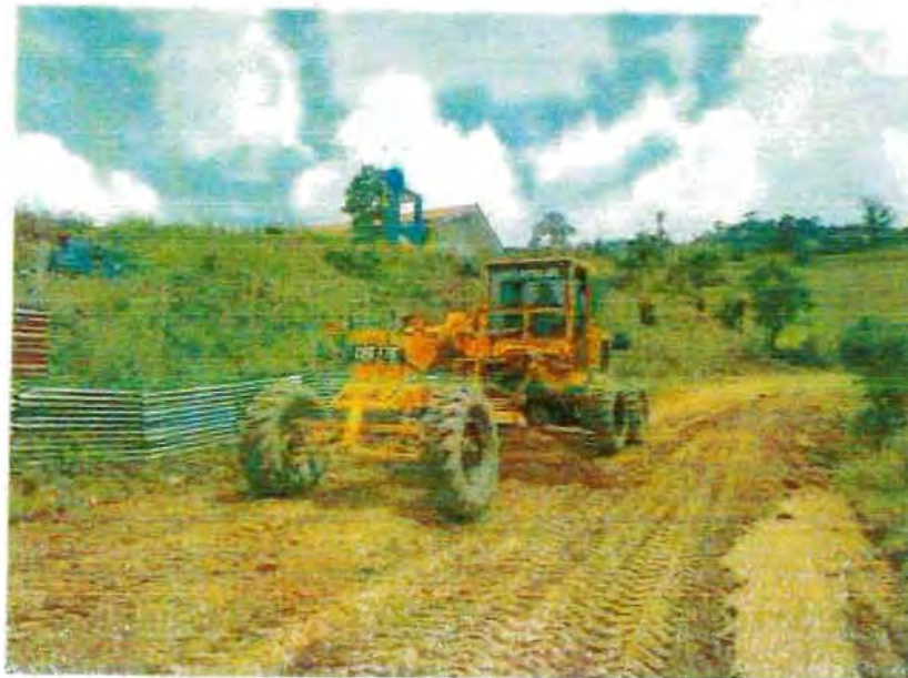
CARGUÍO Y TRANSPORTE DE MATERIAL AFIRMADO SARANDEADO A NIVEL DE RASANTE
