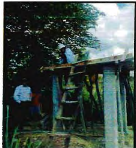
FOTO 31: Supervisión del avance de la infraestructura del proyecto de Las Balsas.
