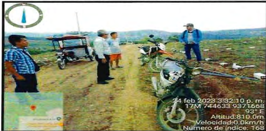
FOTO 46: Imagen de los postes de luz instalados que están en forma perpendicular a la tubería de línea de conducción
