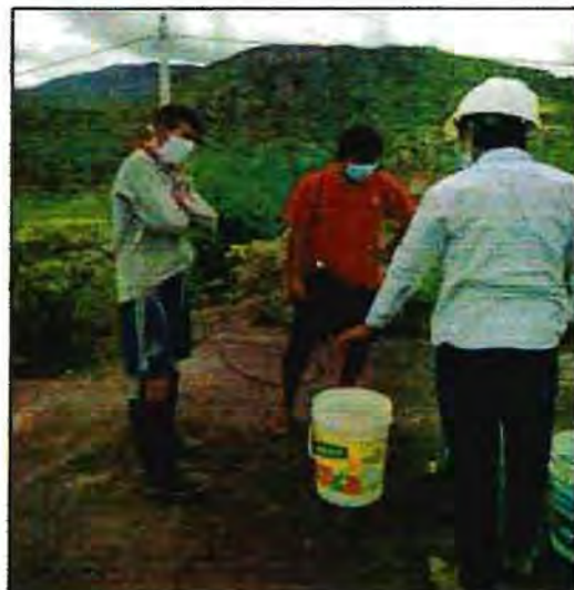
FOTO 59: Inicio del proceso de desinfección y cloración, brindando las pautas establecidas para el manejo y manipulación de los insumos que se van a utilizar, los EPPs son de uso obligatorio en esta actividad.
