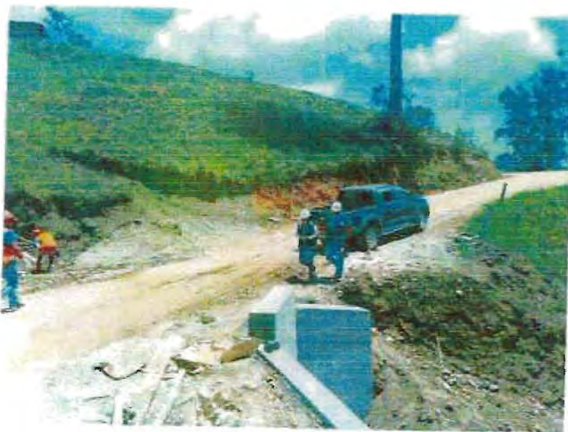
ING. INSPECTOR VERIFICA TRABAJOS EN CAMPO. CONSTRUCCION DE ALCANTARILLAS
