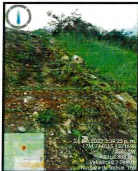
FOTO 45: Imagen de la tubería línea de conducción que abastece el reservorio y que pasa por dicho terreno
