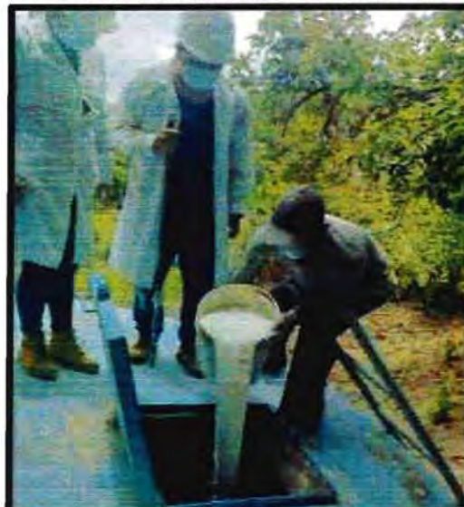
FOTO 10: Desinfección del reservorio.
