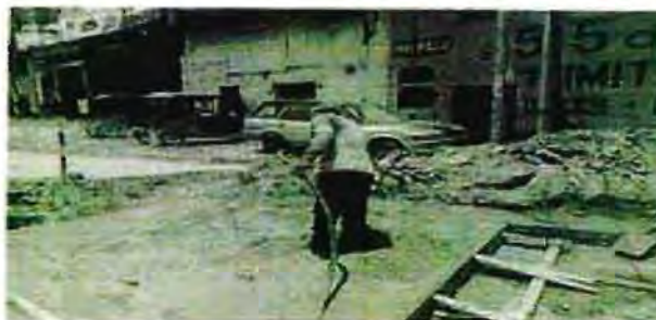
Figura 3 Armado de parrilla de acero
