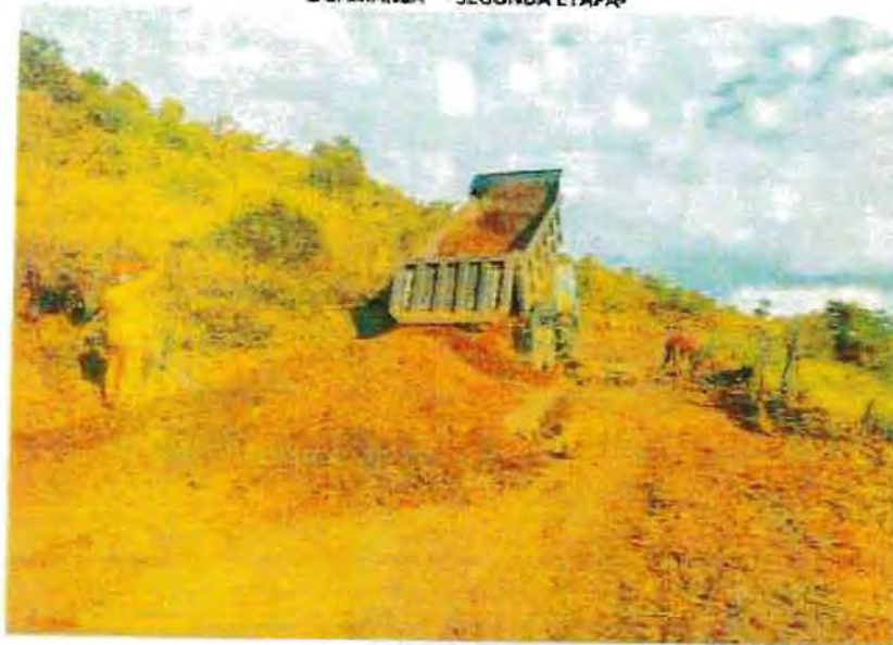
CARGUÍO Y TRANSPORTE DE MATERIAL AFIRMADO SARANDEADO A NIVEL DE RASANTE
