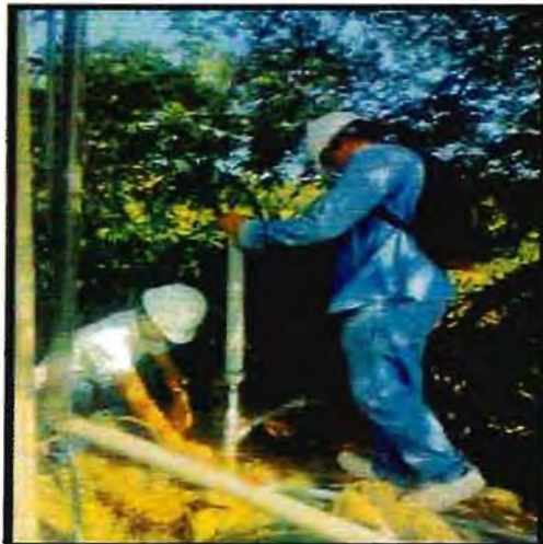
FOTO 34: Construcción y prueba de funcionamiento de la bomba de ariete.
