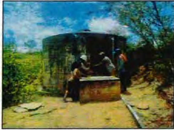
FOTO 52: Reservorio Supervisión a los sistemas de agua y reservorios de la JASS- Chamaya, toma de medidas para establecer los volúmenes de estos, y manejar la distribución del servicio con la finalidad de optimizar las horas de agua que reciben.
