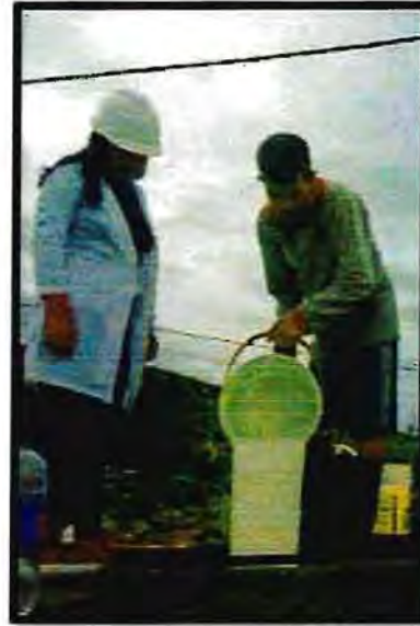
FOTO 13: Desinfección del reservorio.
