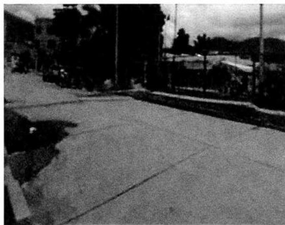
VÍA DE ACCESO EXTERIOR
