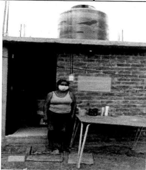
mantenimiento familiar de los UBS y rincón de aseo: familia Cruce Chamaya
