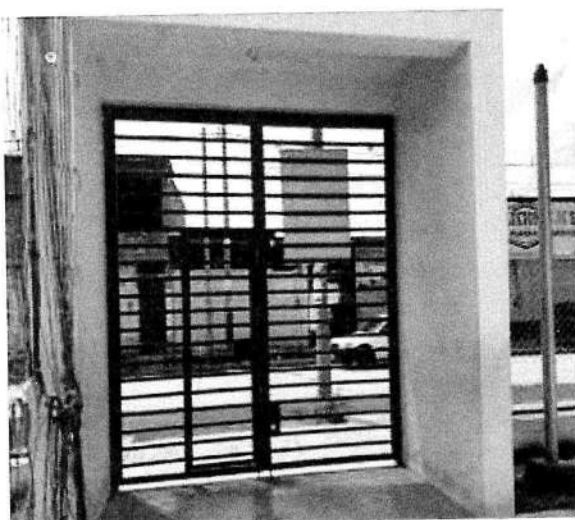
PUERTA DE INGRESO
